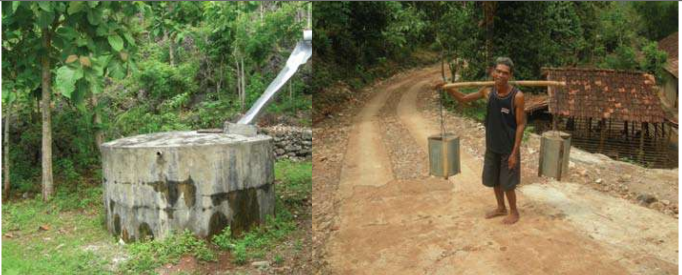
PAH (Penampungan Air Hujan) banyak terdapat di Gunung Kidul, Yogyakarta, disetiap rumah tangga. PAH digunakan untuk menampung air hujan dan air yang mereka dapatkan, dari sumber mata air atau dengan membelinya dari penyalur air setempat yang dijual rata-rata mencapai Rp.100 ribu per tanki mobil.
